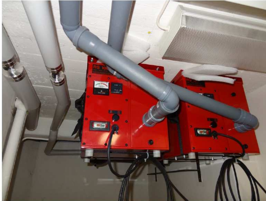
Abb. 1 Installationsbeispiel für einen RS 100-Radonsauger von Corroventa®
