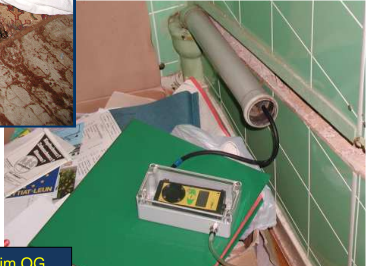
offenes Rohr im OG
